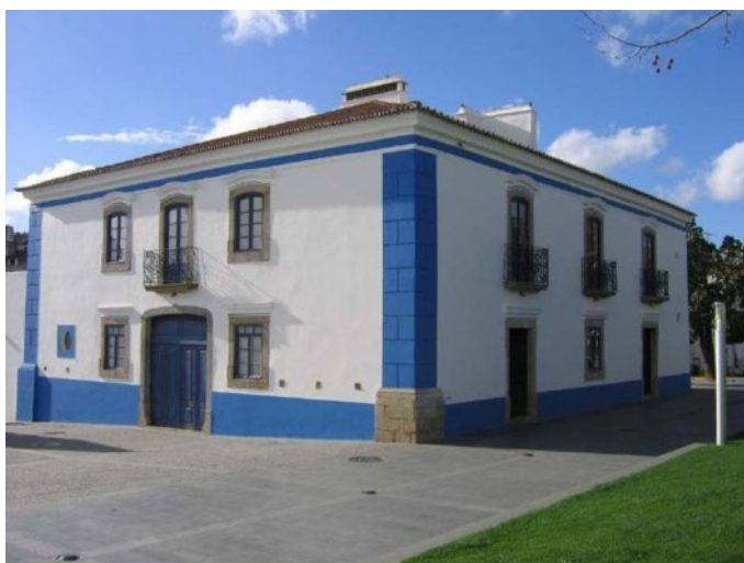
Casa da Mala-Posta, também designada Casa do Capitão -Mor. Atual Biblioteca Municipal de Arraiolos.
