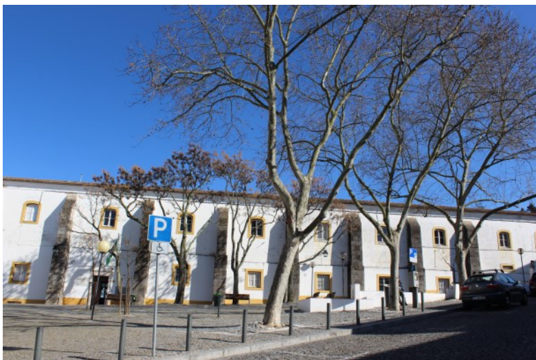
Fig. 6 O antigo dormitório do convento no primeiro andar do edifício.
